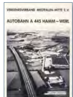
1989 Autobahn A 445 Hamm-Werl. Ein wichtiger Lückenschluß im westfälischen Autobahnnetz
